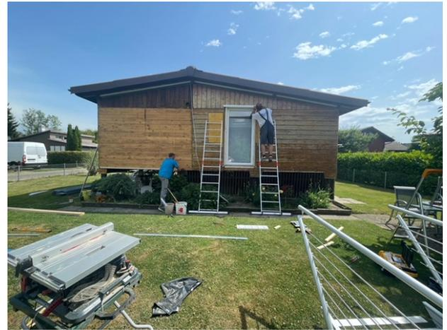
Freilegung der Holzwand und Vorbereitung für den Belüftungsrost. Demontage der Treppe und Satellitenantenne.
